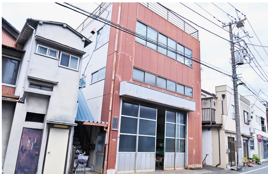
100年近い歴史を有する富澤鉄工所。鉄道車両のブレーキや台車、連結器などの部品製造を担っている
