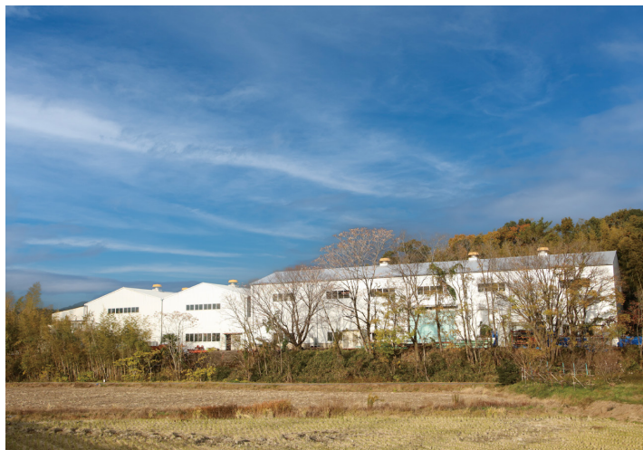
本社と同じ敷地内に工場があり、産業廃棄物焼却処理装置やボイラ、集塵装置などさまざまな装置を製造している
